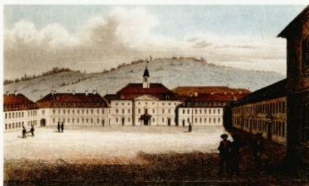
6 Die Herzogliche Militär-Akademie, Karlsschule in Stuttgart
