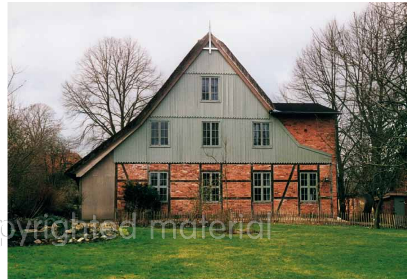
Ansicht des südöstlichen Giebels nach Abschluss der Sanierungs- und Umbauarbeiten.
