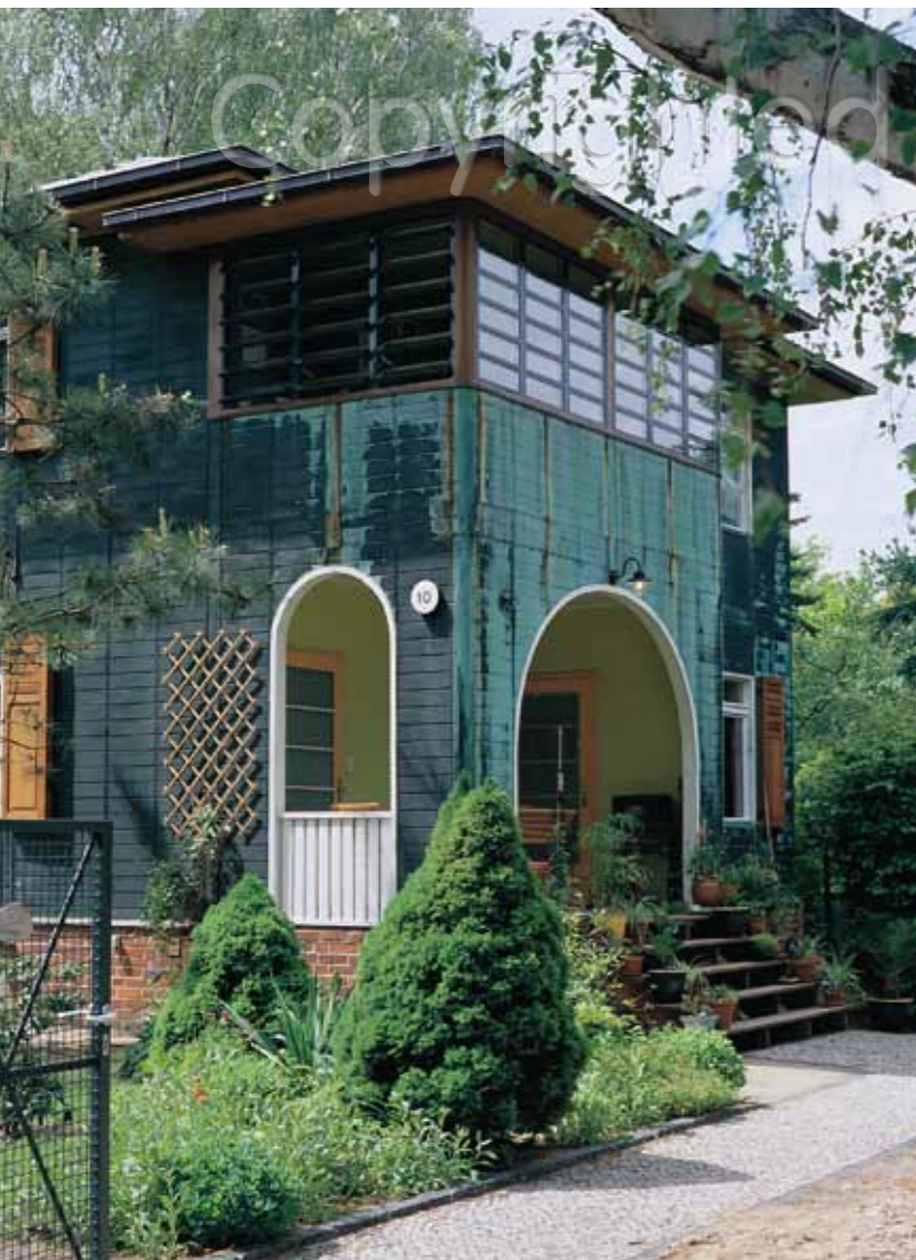
Gesamtansicht des »Kupferhauses« nach Sanierung und Umbau von Nordosten. Die Eingangsloggia im Erdgeschoss wird besonders gerne als Frühstücksterrasse genutzt.
