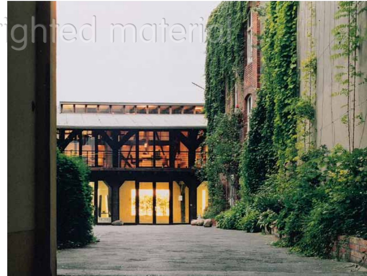
Blick durch den Hof zum »Loft-Schuppen« mit nun komplett verglastem Fachwerk.
