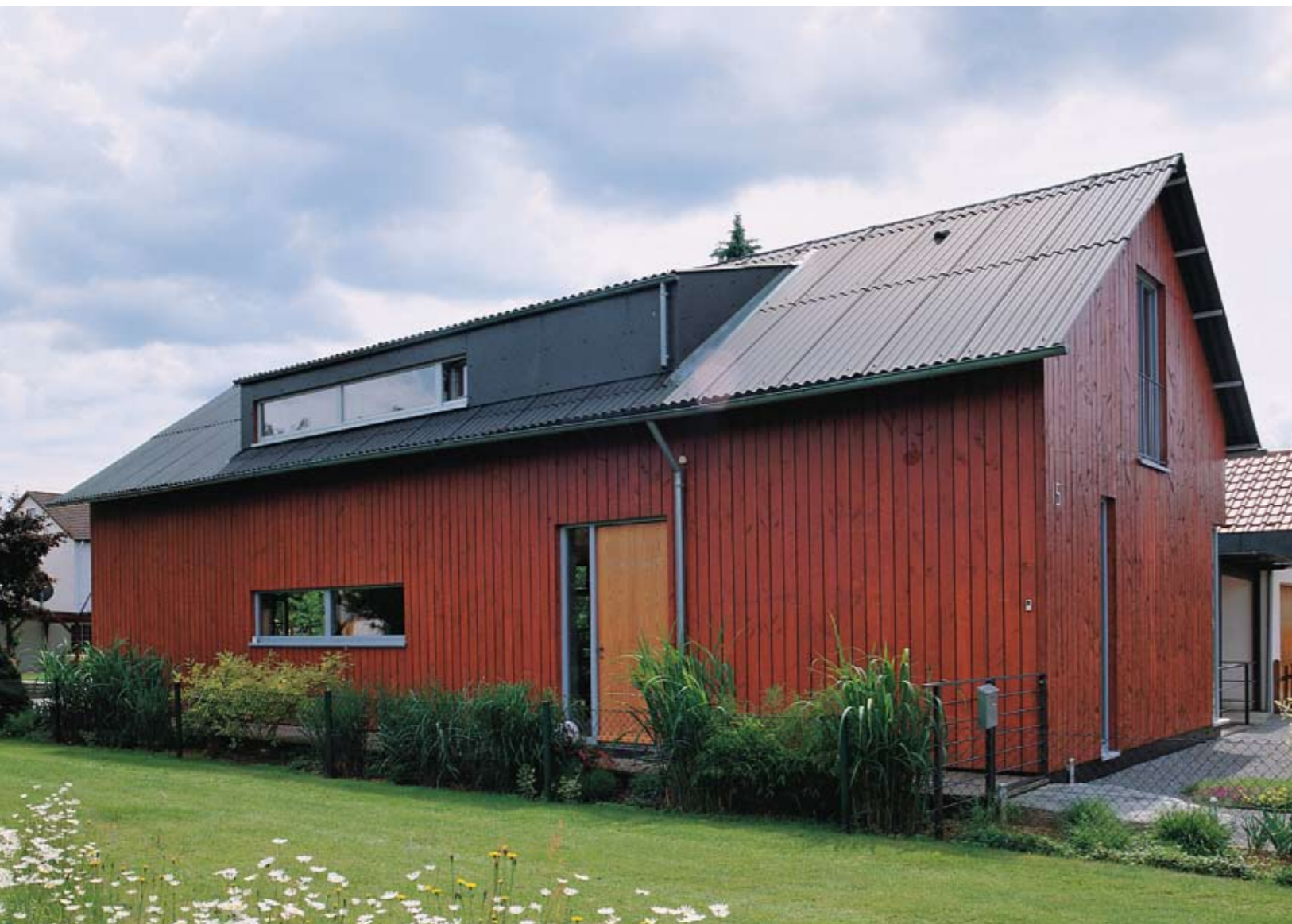
Die Ostseite stellt sich eher geschlossen dar und weist nur die notwendigsten Belichtungsöffnungen auf.
