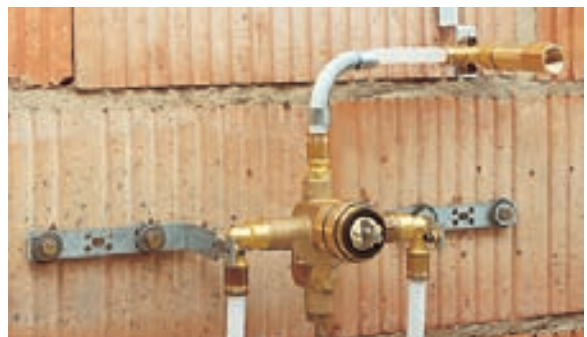
3 Anschlusswinkel – hier mit Wandscheibe für den Anschluss einer Wandeinbaubatterie und eines Brauseschlauchs
