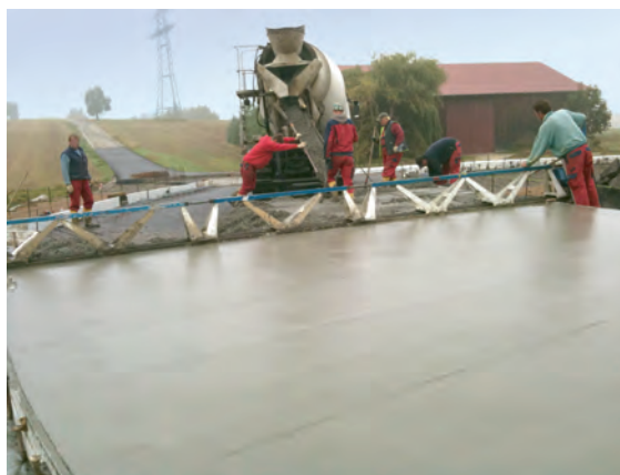
Herstellung einer Kreisverkehrsfläche im Handeinbau
