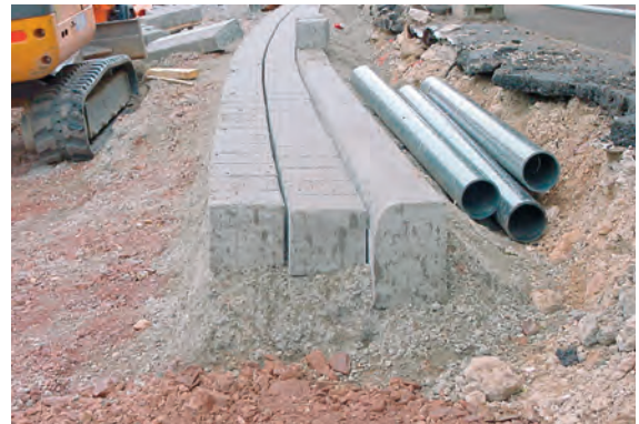
Bord- und Rinnensteine in Betonbettung
