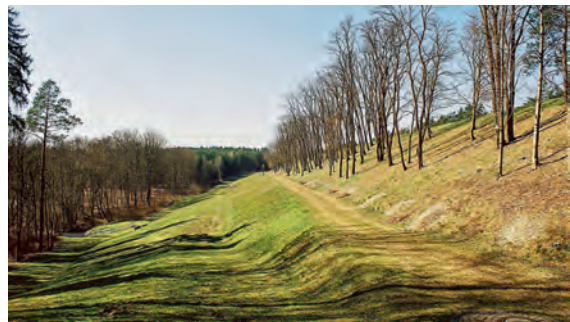
Böschung mit Berme
