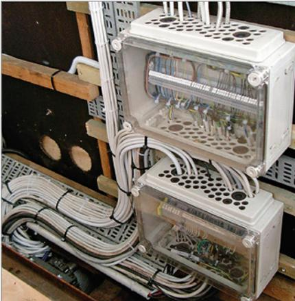
**Abbildung 4-30:** Rangierverteiler mit Reihenklemmen im Verteilergehäuse aus Kunststoff mit Moosgummi-Kabeleinführungen in IP 54.
