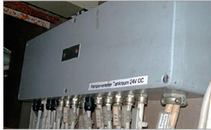
**Abbildung 4-32:** 24-V-Verteilung aus Aluminium mit PG-Verschraubungen und Reihenklemmen.
