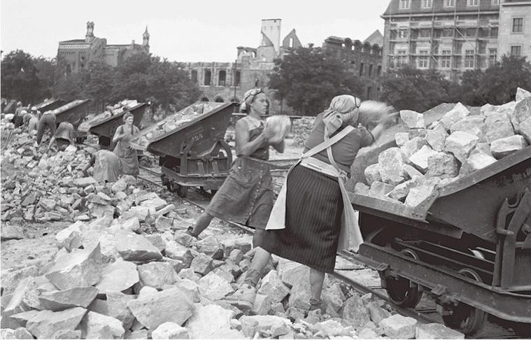
Zur «fachgerechten Großentrümmerung» gehörte der Aufbau eines Transportsystems. Die Trümmerbahn von Dresden fuhr auf sieben Schmalspurlinien mit 40 Kleinlokomotiven, die alle weibliche Vornamen trugen.
