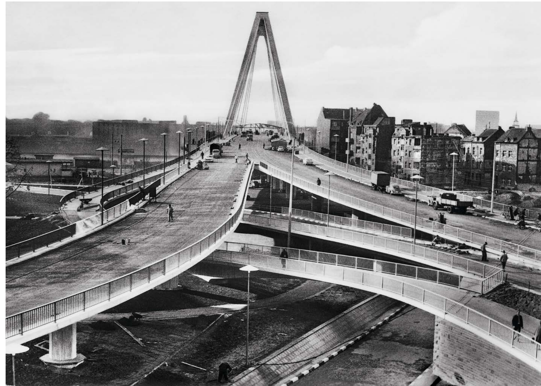
Severinsbrücke mit einer autogerechten Verkehrsführung kurz vor Beendigung der Bauarbeiten, 1959, Fotograf unbekannt
