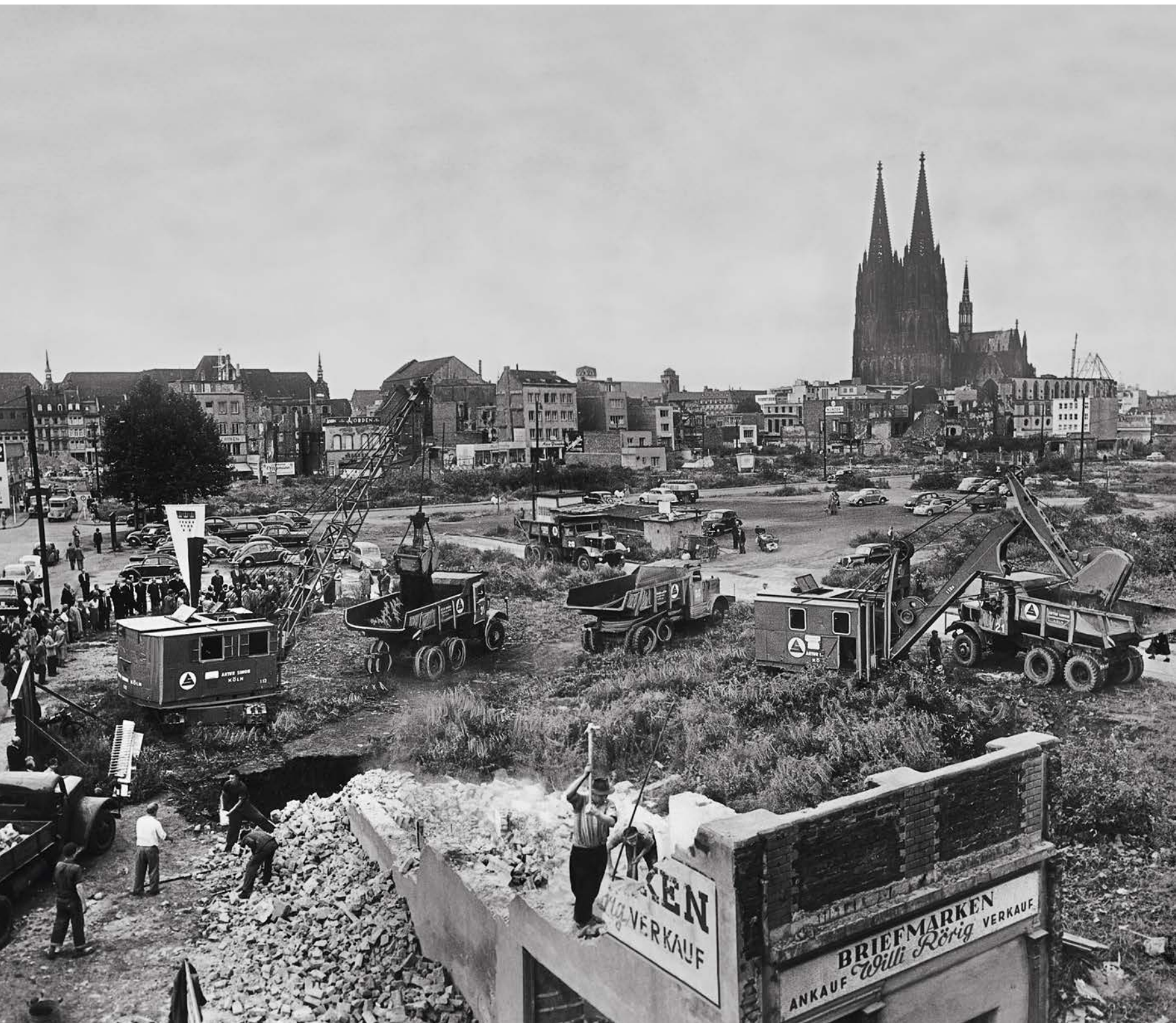
Erster Spatenstich zum Bau der neuen Oper am 13. September 1954 nach Plänen von Wilhelm Riphahn, Foto: Helmut Koch
