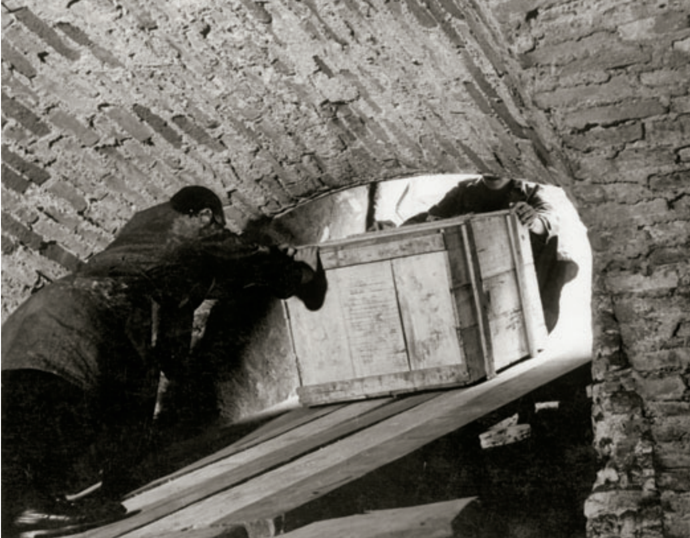
◀ 5 Über Brettterrassen und durch Kellerfenster wurden die Transportkisten aus dem Ägyptischen Museum geschafft.
