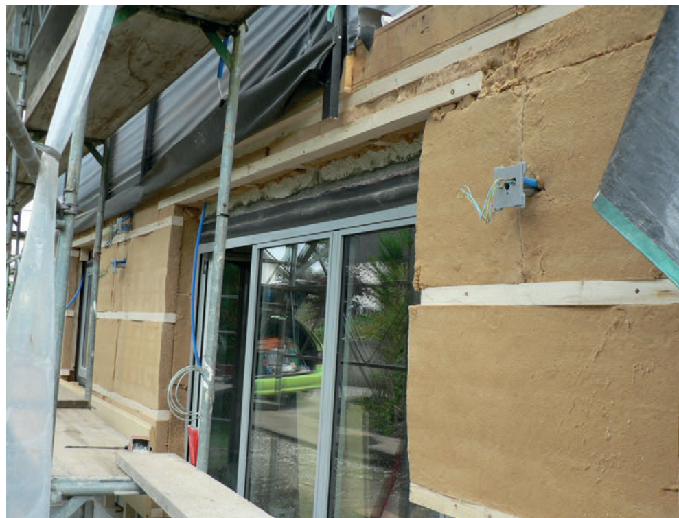
Nachdem die bestehende Mauerwerkswand mit weicher Holzfaserdämmung überdämmt wurde, wird ein Holzrost mit Winddichtung ausgeführt und die Fassadenschalung als Witterungsschutz aus vorvergrauter Lärche und Leichtbauplatten ausgeführt [E].
