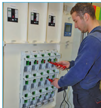
Bild 4: Überprüfen der Spannungsfreiheit mit einem zwei-poligen Spannungsprüfer
