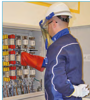
Bild 2: Elektrofachkraft beim Ziehen eines NH-Sicherungseinsatzes
