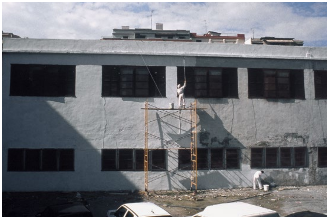
Restaurierung des Marktes im Stadtviertel Gros wenige Tage vor dessen Abriss / Restoring the Gros Market a Few Days Before its Demolition, San Sebastián, 1995.
