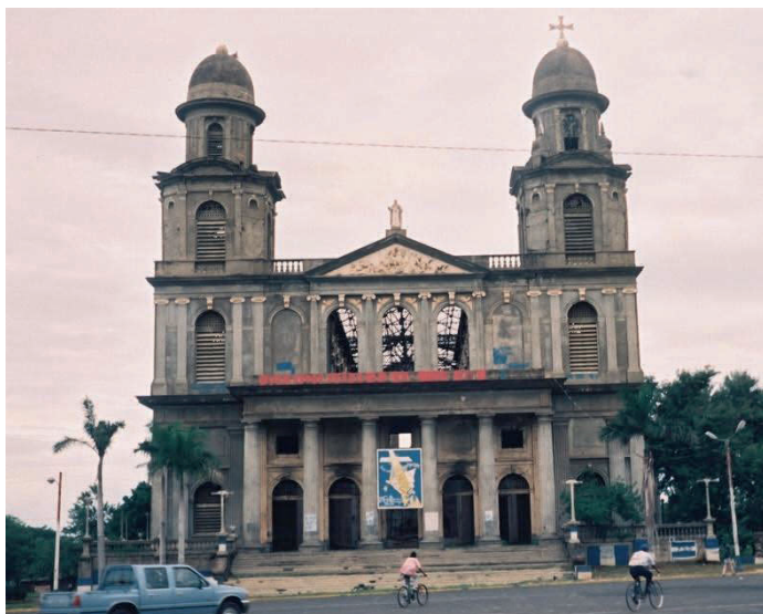
Die vom Erdbeben zerstörte Kathedrale in Managua.
