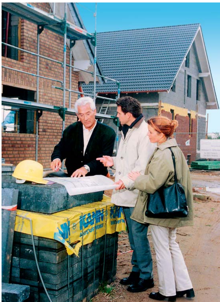
Der Generalübernehmer sollte am besten die gesamten Planungs- und Bauleistungen „aus einer Hand“ liefern.
