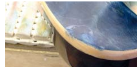
Abb. 3.2.1.11: Reparaturstelle fertig zum Polieren
