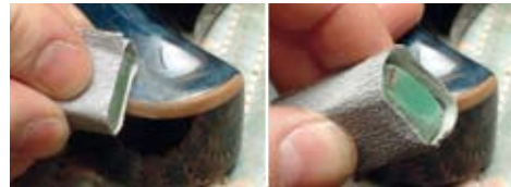
Abb. 3.2.1.9: Die Schadstelle wird fein geschliffen: Das Radiergummi dient als flexibler Schleifklotz
