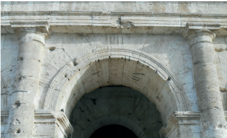
Abb. 4: Rom, Kolosseum, Fassade, erstes Geschoss, Eingang III mit dorisierenden Kapitellen und ionischem Gebälk.
